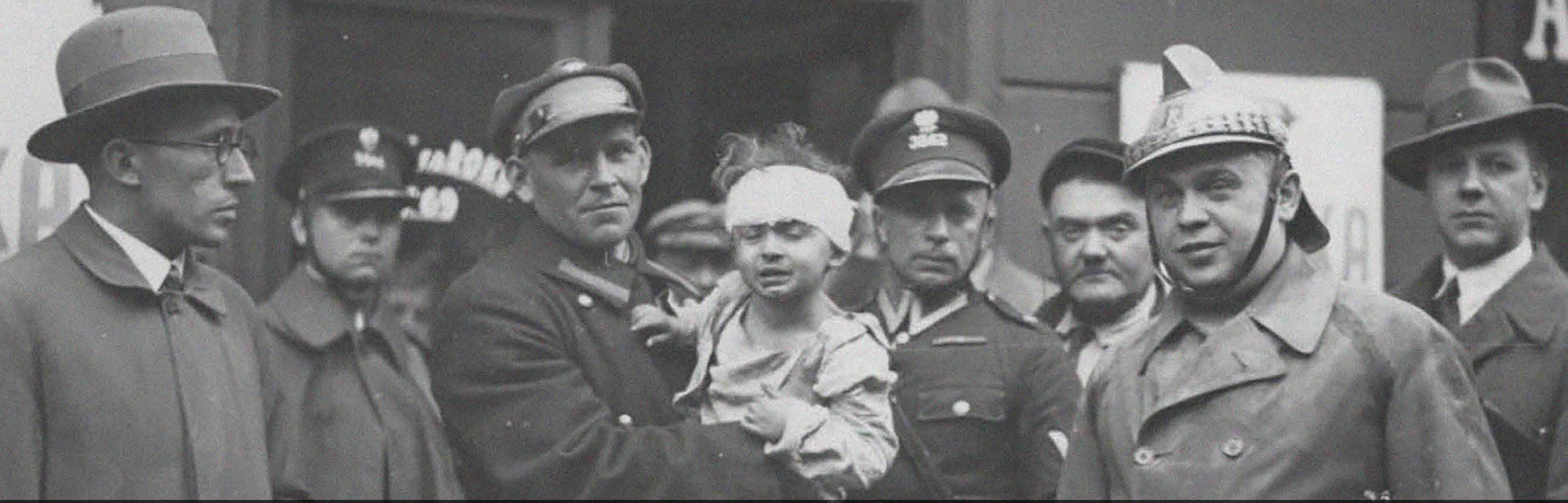
Katastrofa budowlana w kamienicy przy ul. Freta 16 w Warszawie. 31.07.1935 r.
